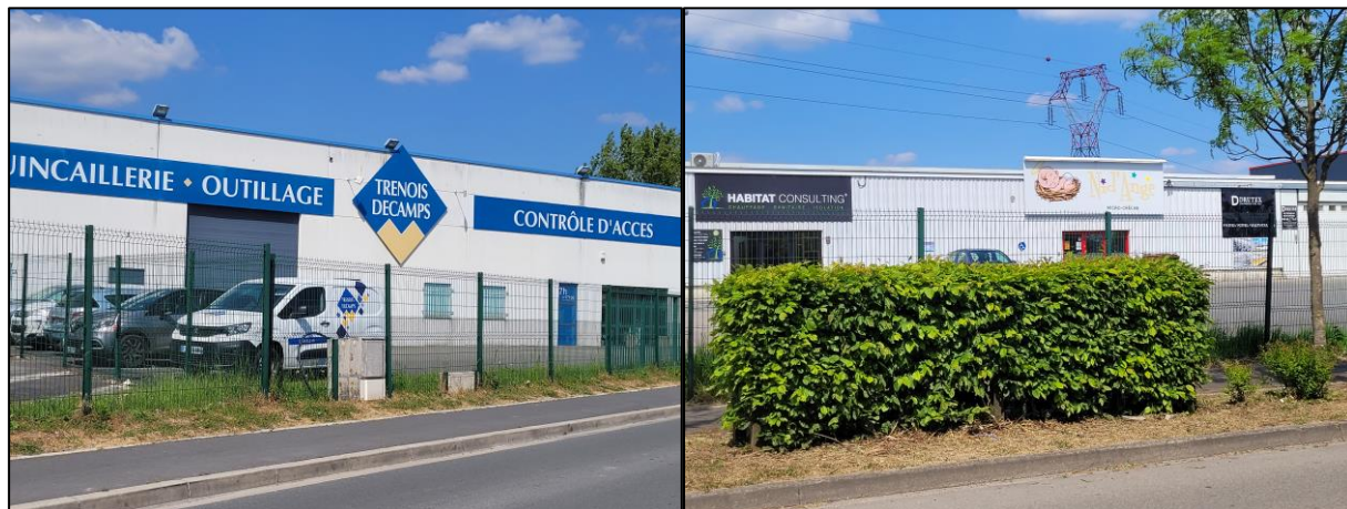
Exemples d'enseigne en bandeau dépassant la limite du toit
