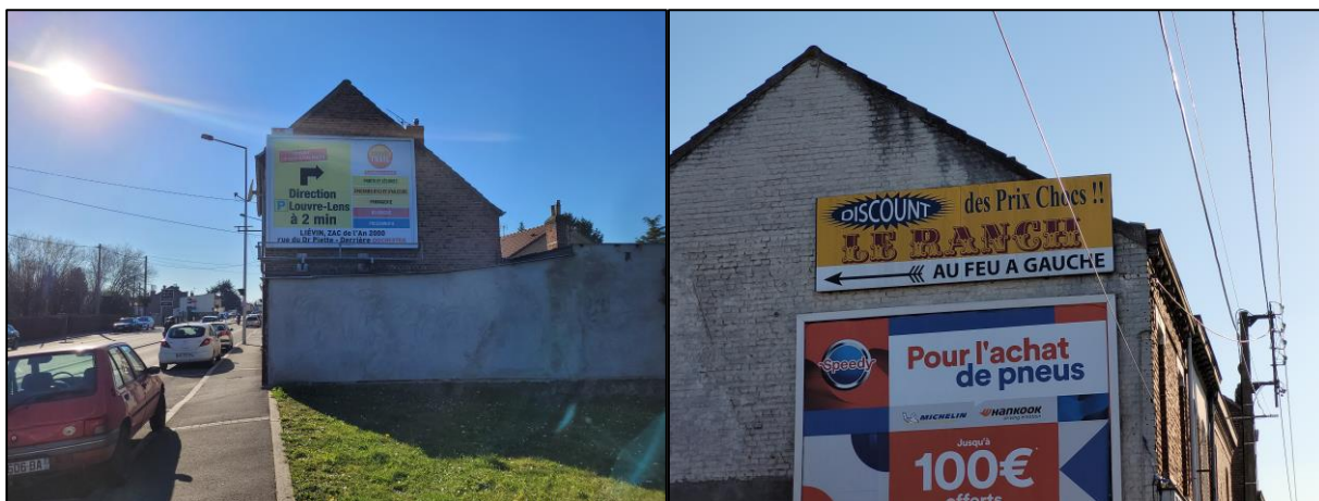
Exemples de publicité dépassant l'égout du toit
