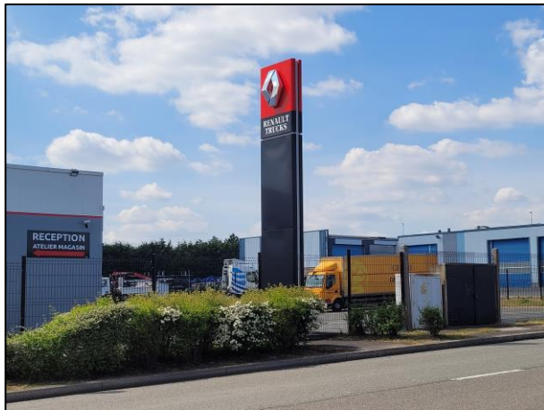
Exemple d'enseigne en totem (scellée au sol)
