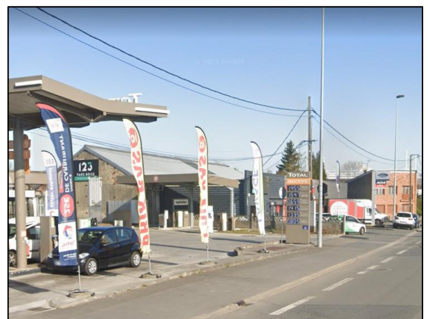
Exemple d'enseigne posée directement au sol
