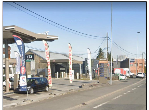
Exemple d'enseigne posée directement au sol
