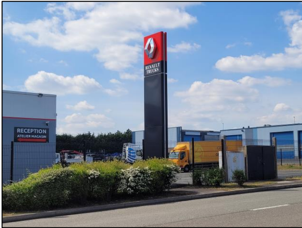
Exemple d'enseigne en totem (scellée au sol)
