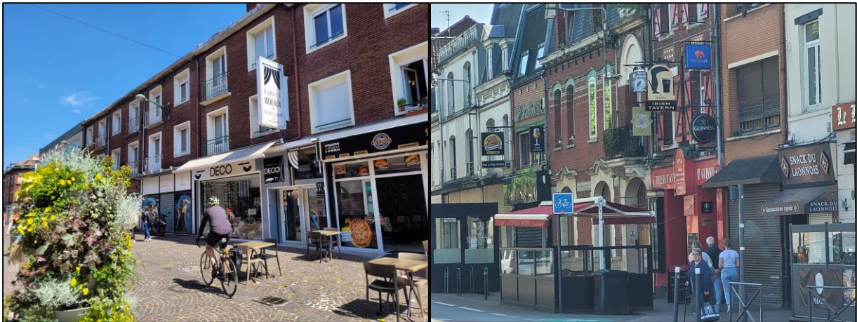
Exemples d'enseigne en drapeau installée au-dessus du rez-de-chaussée
