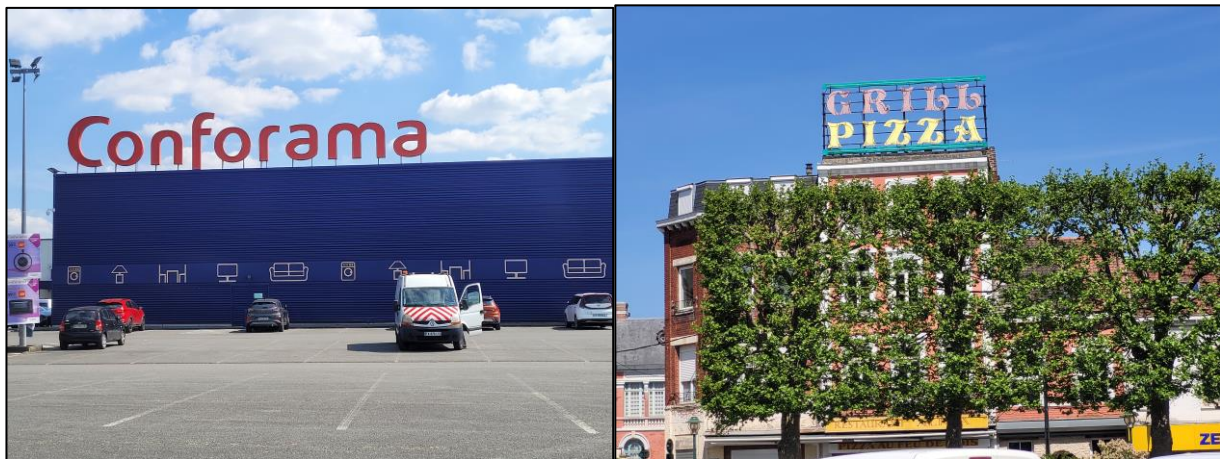
Exemples d'enseignes en toiture
