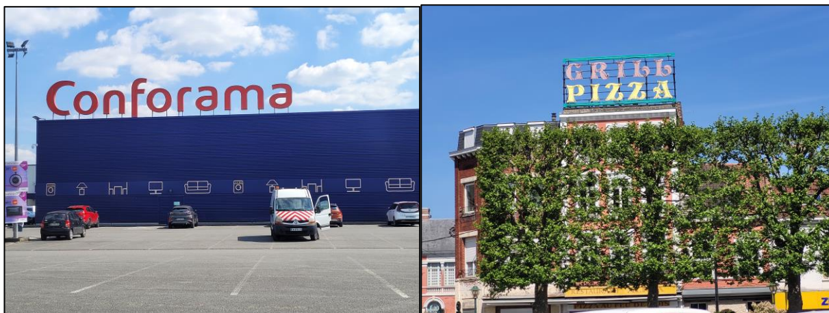
Exemples d'enseignes en toiture
