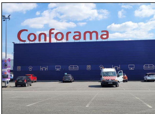
Exemple d'enseigne sur toiture
