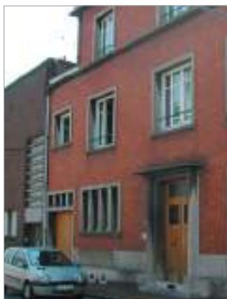
Baies encadrées (cadre saillant en béton) ou non (appui et linteau béton)
