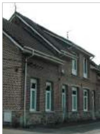
Un appareillage de meulière à joint rubané (total ou partiel en soubassement)
