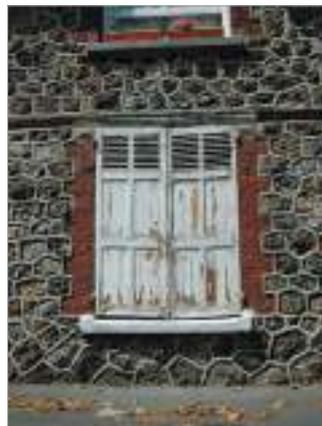
Quelques volets bois battants subsistent, à encadrement persienné en partie haute
