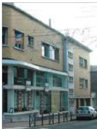
Une composition de façade mise en valeur par des parties enduites ou recouvertes d'un matériau différent de la brique (fausse pierre...)
