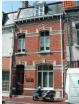
Une maçonnerie de briques animée par un jeu d'éléments saillants (cordons, appuis), une modénature particulière (frises, linteaux) et des éléments enduits (linteaux, pilastres...)
