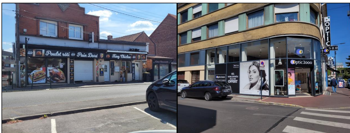
Exemples d'enseigne en bandeau dépassant les pourcentages autorisés
