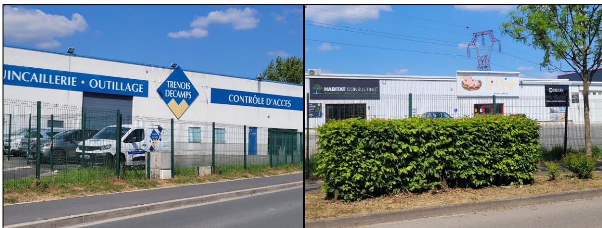
Exemples en bandeau dépassant les limites du mur
