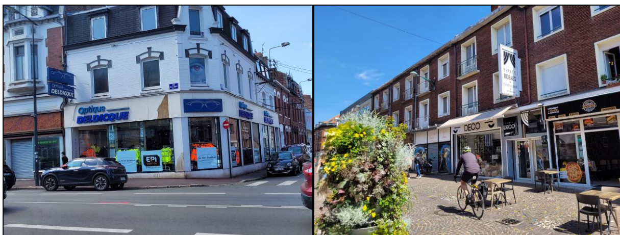
Exemples d'enseigne en drapeau dépassant la surface autorisée
