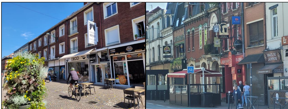
Exemples d'enseigne en drapeau installée au-dessus du rez-de-chaussée
