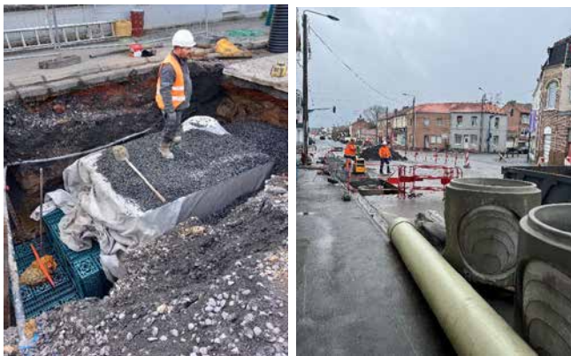
Bassin d'infiltration sous parking – Renouvellement du réseau d'eaux usées
