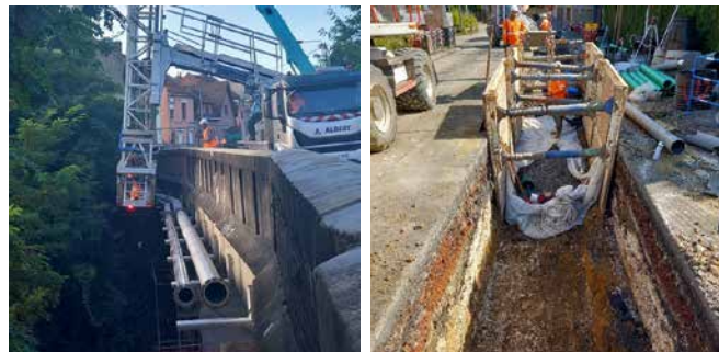
Construction du bassin d'infiltration au niveau de l'aire de retournement
