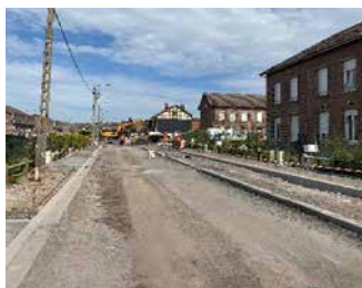
Travaux d'aménagement cité des Genettes - Liévin
