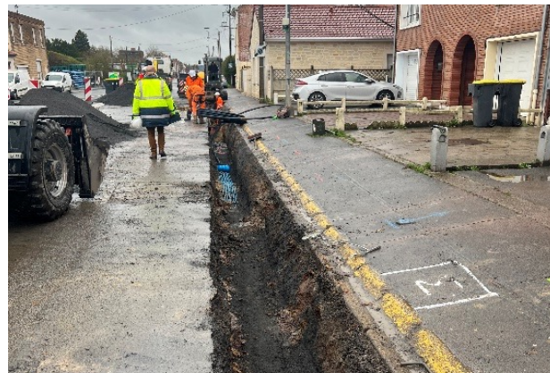
Pose de la conduite eau potable sur le boulevard Henri Martel
