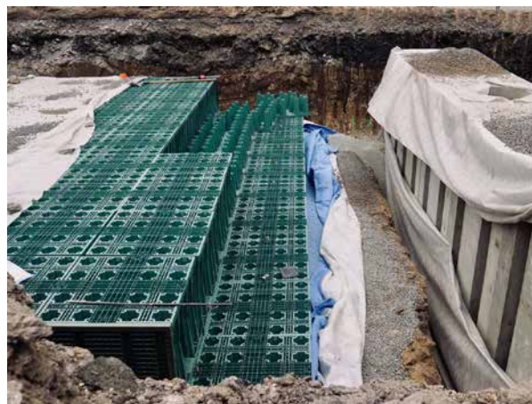
Wingles, rue de l'électrolyse
