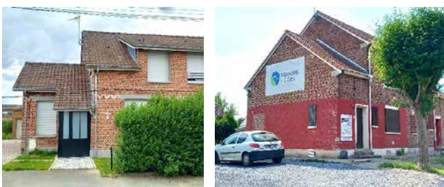
Logements réhabilités Cité 10 de Sains-en-Gohelle, Cité du Parc à Méricourt et Cité 5/12 de Sallaumines
