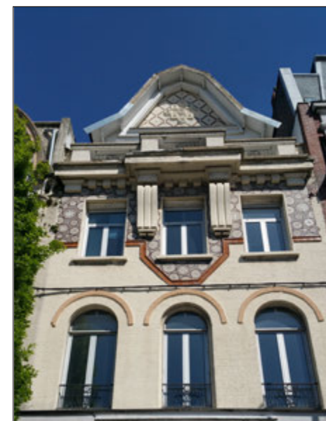
Photographie de l'édifice. Source : GRAHAL
