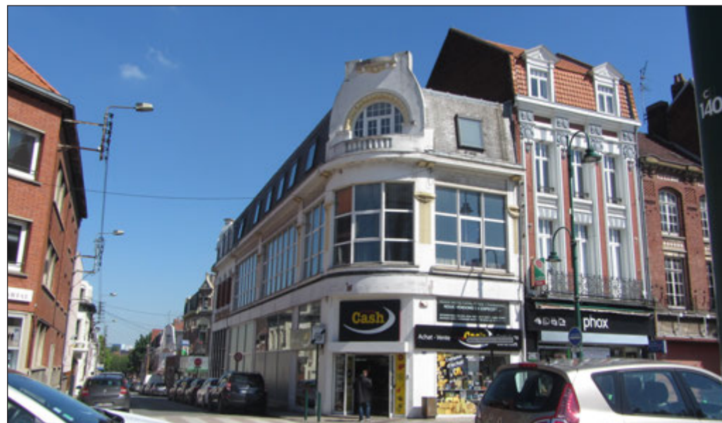
Photographie de l'édifice. Source : GRAHAL
