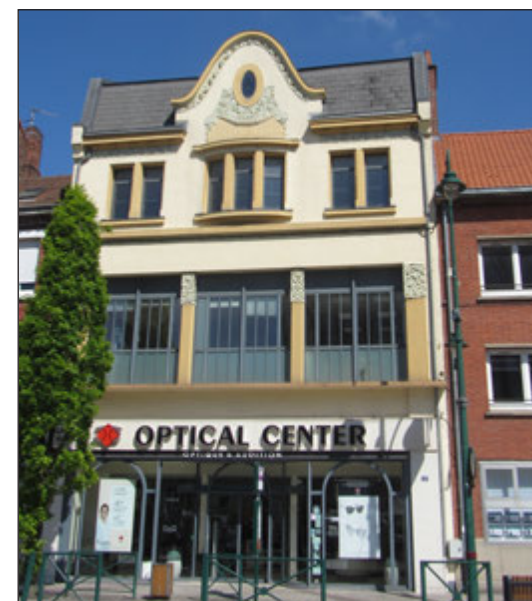
Photographie de l'édifice. Source : GRAHAL
