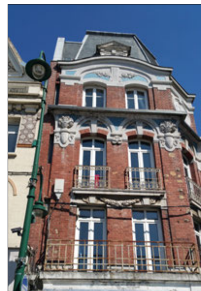
Photographie de l'édifice. Source : GRAHAL
