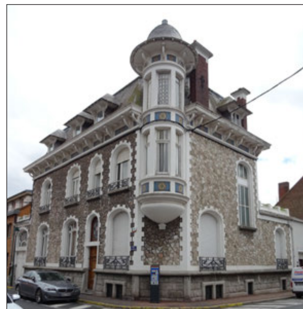
Photographie de l'édifice. Source : GRAHAL
