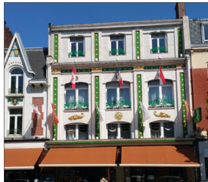
Photographie de l'édifice. Source : GRAHAL
