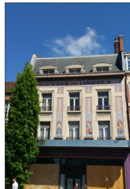
Photographie de l'édifice. Source : GRAHAL
