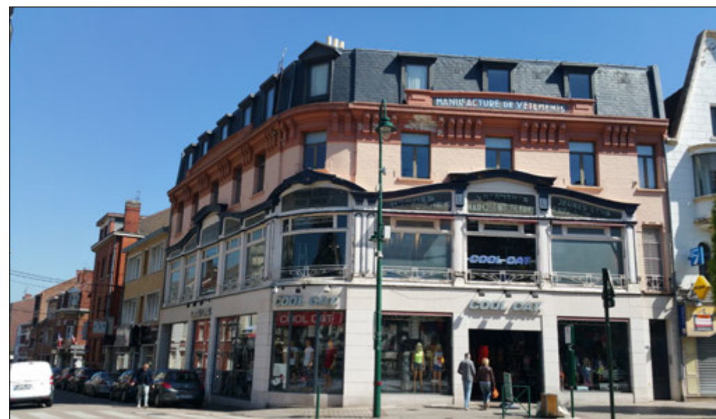
Photographie de l'édifice. Source : GRAHAL
