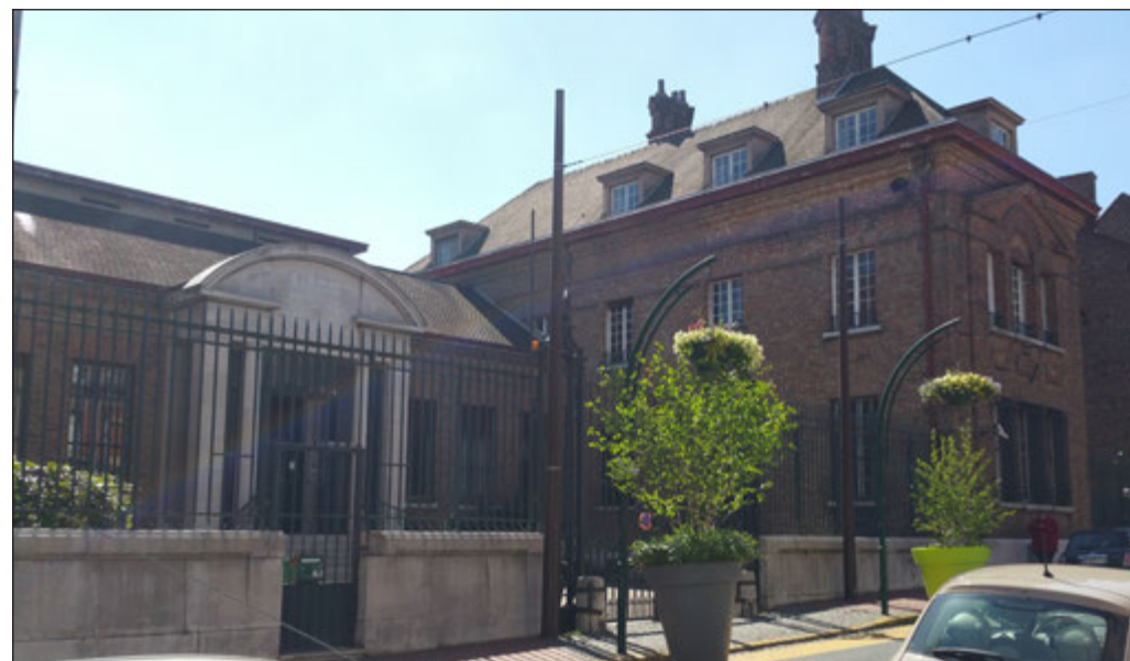
Photographie de l'édifice. Source : GRAHAL
