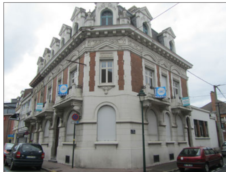
Photographie de l'édifice. Source : GRAHAL
